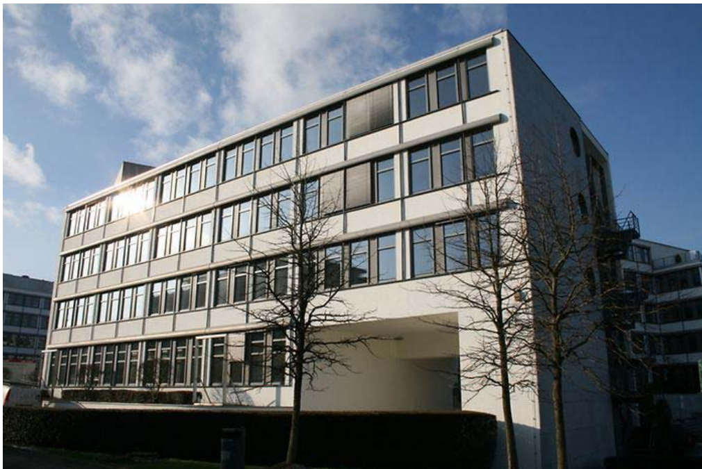
L'ancien bâtiment de PwC, où des travaux de rénovation ont débuté cette semaine Photo: Dominique Nauroy
