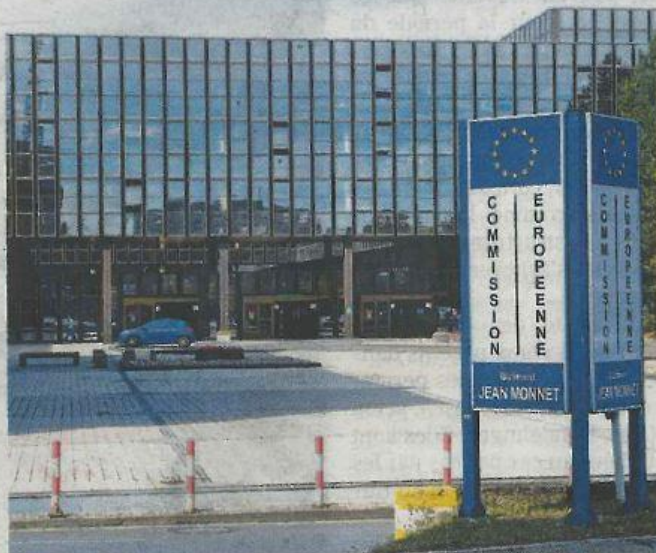
Le bâtiment Jean-Monnet va être vidé d'ici la fin de l'année 2015.
